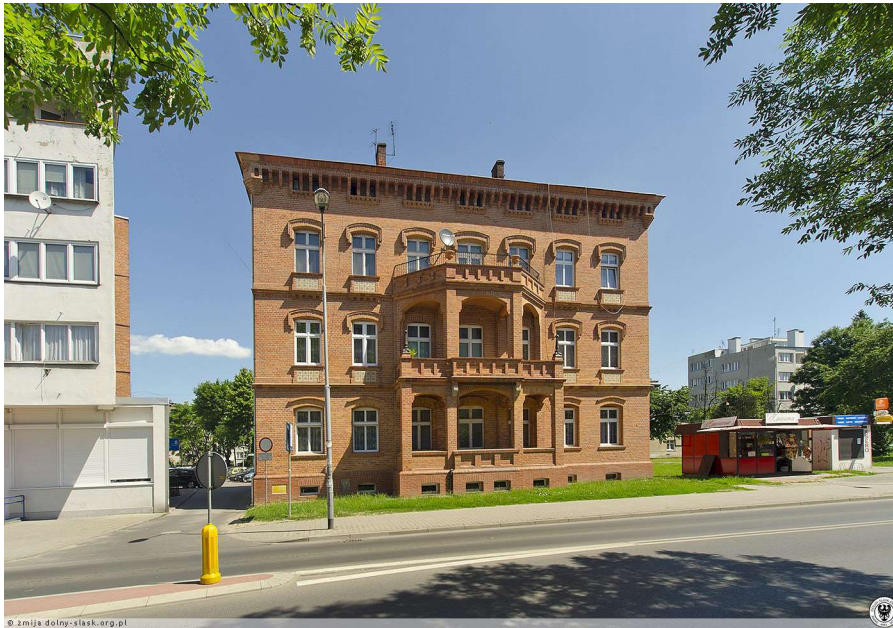
Das Haus an der Reja 14–15 in Oleśnica (früher die Bahnhofstraße in Oels) 174
